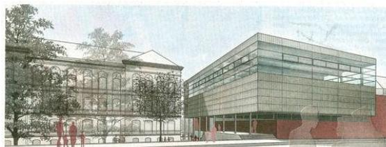
Die Sporthalle am Werner-Heisenberg-Gymnasium (links) bekommt zwei Etagen und ist damit ein Novum in Leipzig. Im Obergeschoss entsteht eine 22 mal 44 Meter große Zweifelhalle, im Erdgeschoss eine Einfeldhalle für die Kinder der 39. Schule. Entwurf: RKW
